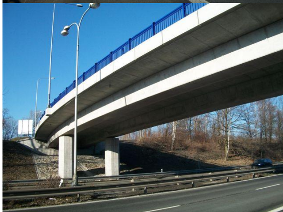
Most ev.č. 23-009 Barborka u Jindřichového Hradce
