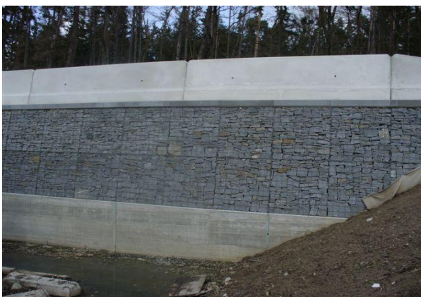
Gabionová stena – objekt SO 210 pri ceste III/121113 Nová Hospoda
